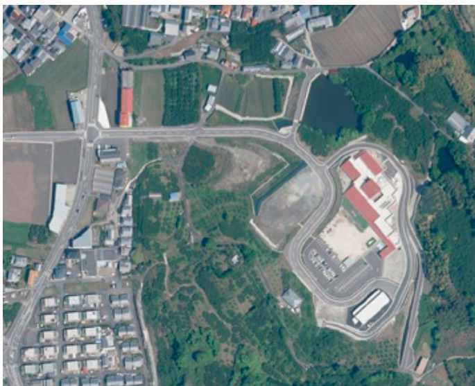
公共工事として開発した小山田防災拠点 (上：造成前 下：現状)
