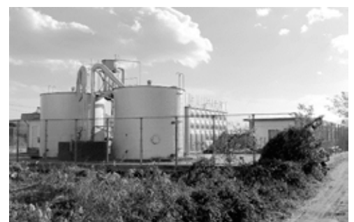
▲南部川河川敷の浄水場の耐震化も急がれる。
