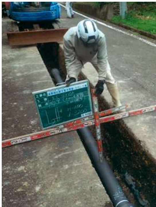
▲水道管の耐震化は、基幹管路からスタート
