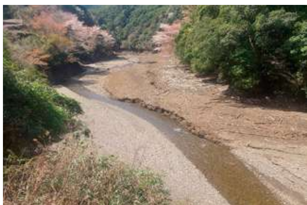
ダム上流には大量の土砂が堆積
