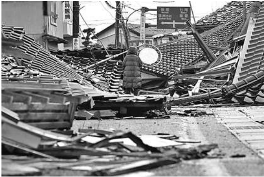
道をふさぐ倒壊住宅(珠州市) 静岡新聞より
