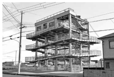
津波避難タワーの一例(田辺市)
