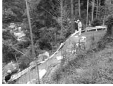
滝地内の災害現場
