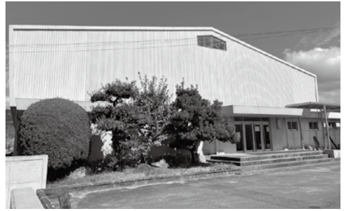
上南部中学校体育館
