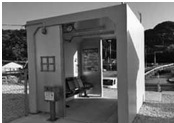
▲コンパクト化された駅舎
