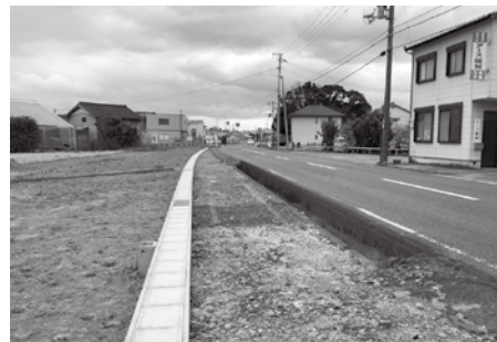
国道424号線歩道拡張工事
