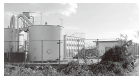
南部川河川敷にある浄水場
