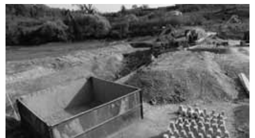
ハス池堤体（土手）工事現場
