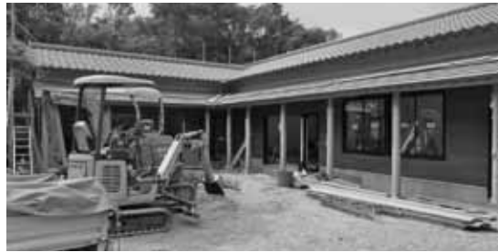
建設中の「千里ウミガメ館」
