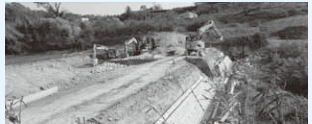
はず池改修工事現場
