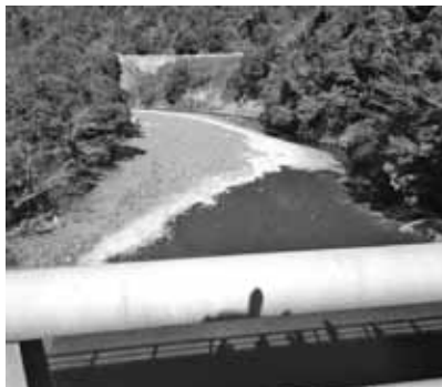
土砂が堆積して川ようになったダム上流
