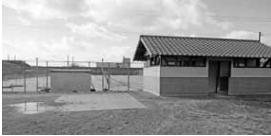
元テニスコート協の撤去予定のトイレ
