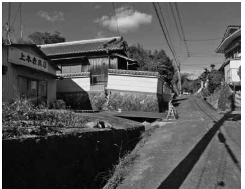
芋畑地区の陥没現場
