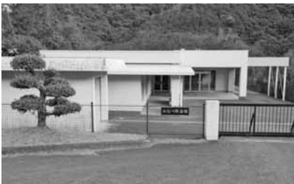
みなべ町斎場
