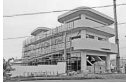
工事中の津波避難タワー（11月末に完成予定）
