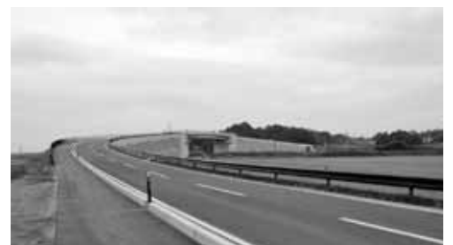
立体交差になった「大富希望の橋」
