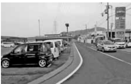
完成したグリーンベルト（バリューハウス横）
