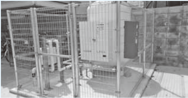
空調設備（上南部中学校 ガス方式）
