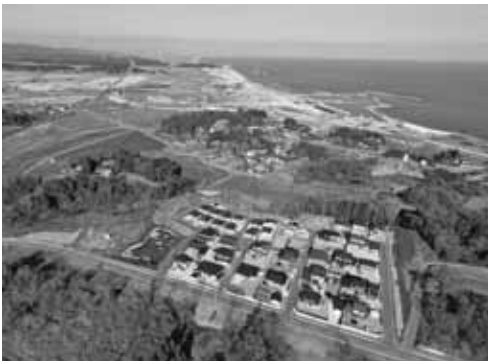
造成が完了した大戸浜団地
