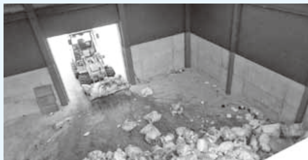
すさみ町ゴミ焼却場
