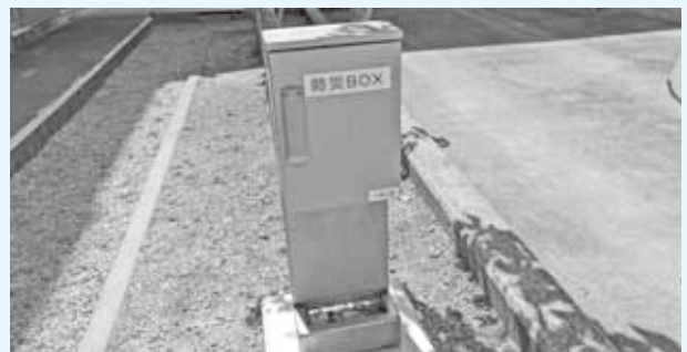
震度感知自動開錠式鍵収納ボックス（南部小学校）
