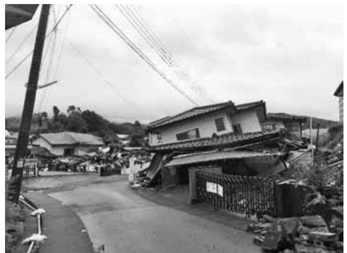
1階部分が完全に倒壊
