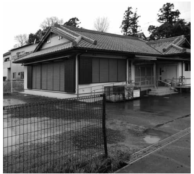
借地の例(上南部地区介護予防センター)
