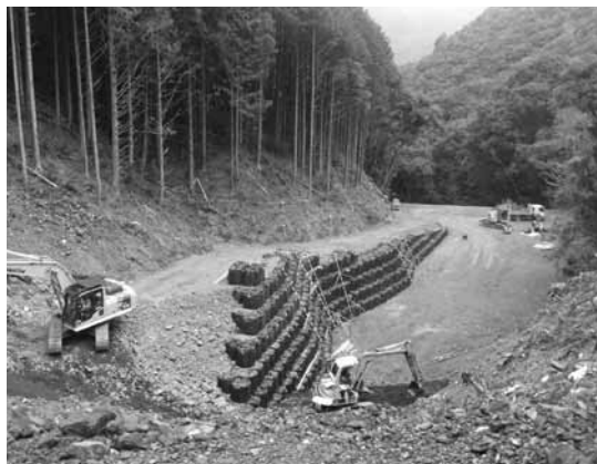
県道芳養清川線工事現場
