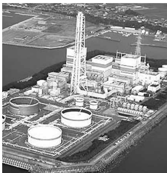
御坊火力発電所
