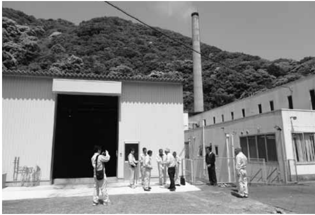
すさみ町ゴミ焼却場
