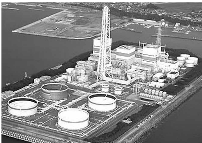
御坊火力発電所
