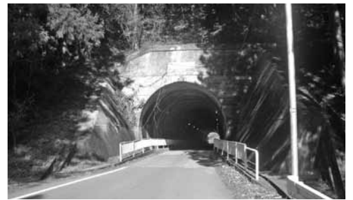
高城トンネル
