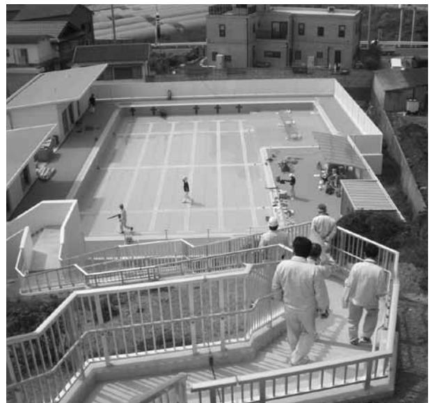
岩代小学校プール
