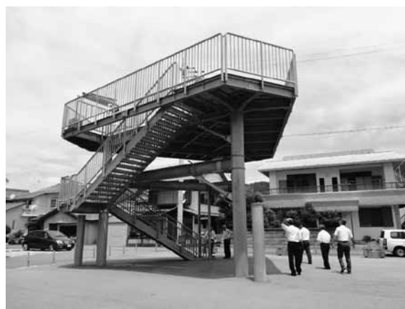
津波避難タワー
