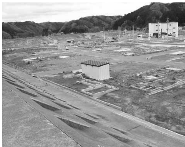
基礎だけ残っている旧住宅地(田老地区)
