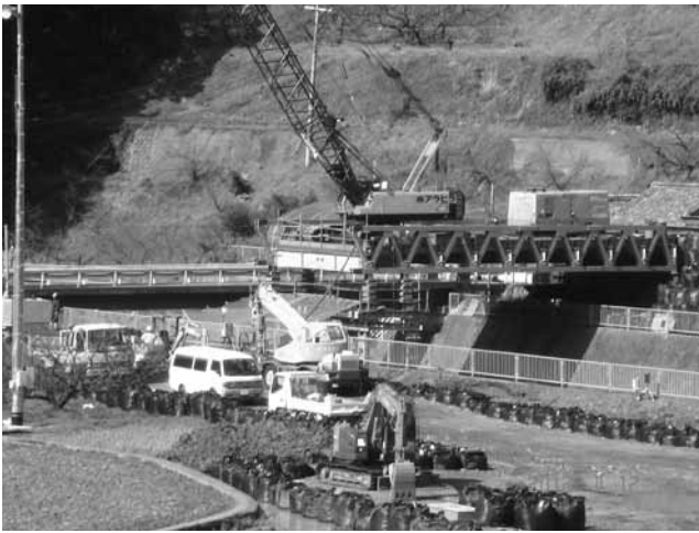
国道424号 清川地区
