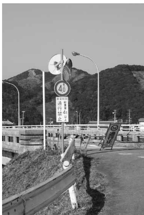
通行止めの旧西本庄橋
