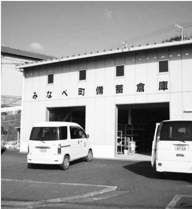
備蓄倉庫(埴田)
