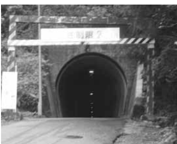
面谷トンネル
