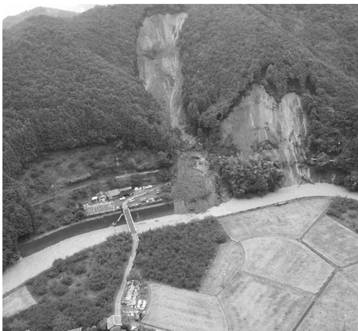
通行不能になった国道424号
