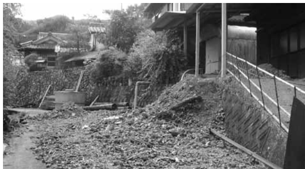
土砂流れ出し現場(清川)
