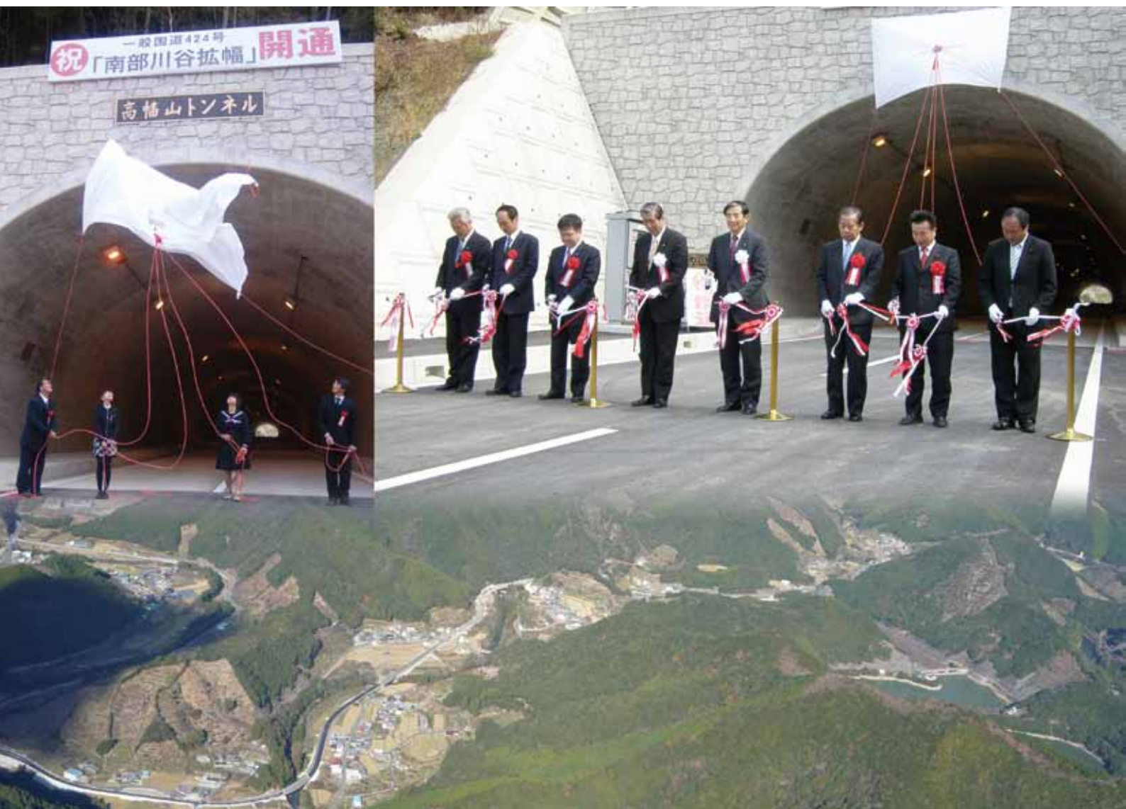
開通した国道424号(高城工区)
