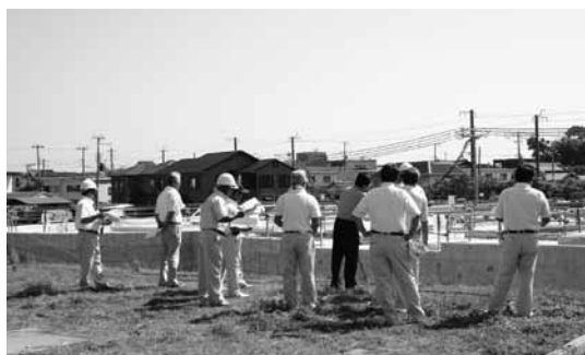
浄化センター工事現場
