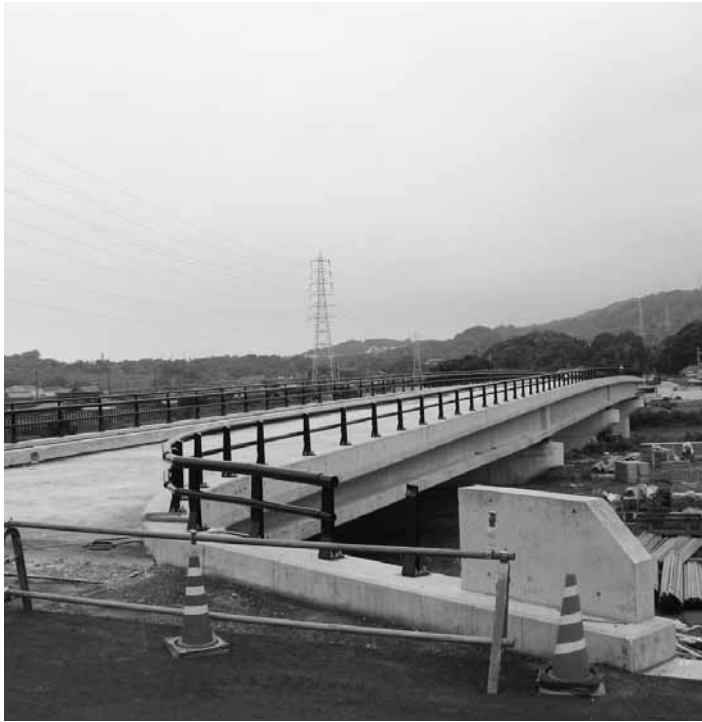
完成間近な「みなべ新橋」
