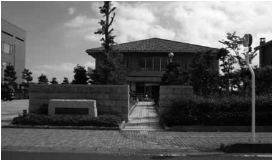
浄化センター
