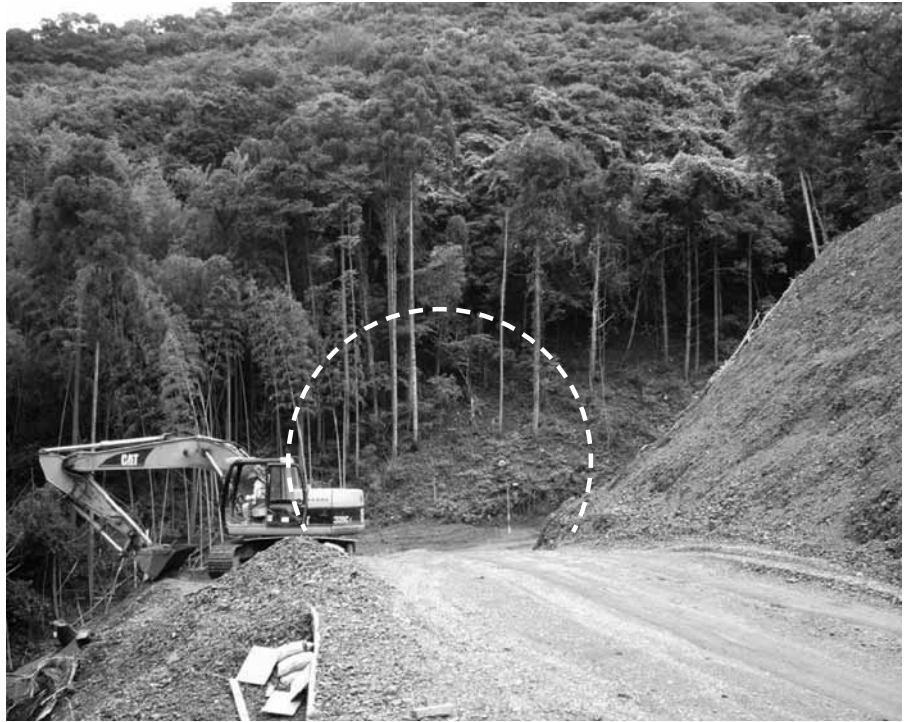
小倉谷トンネル工事（予定地）
