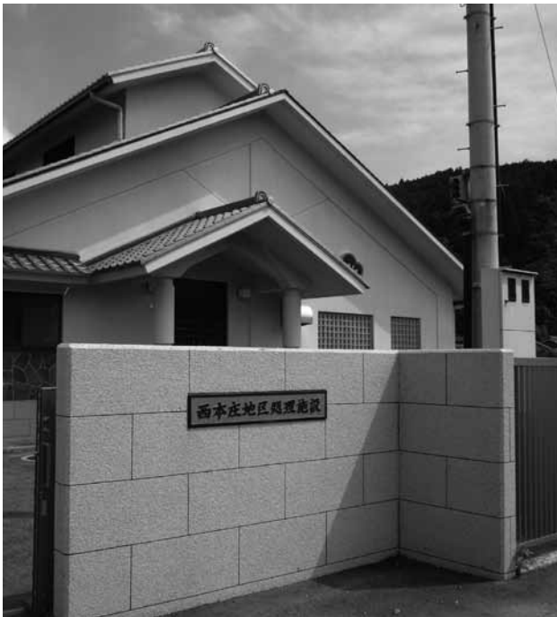
農業集落排水処理センター
