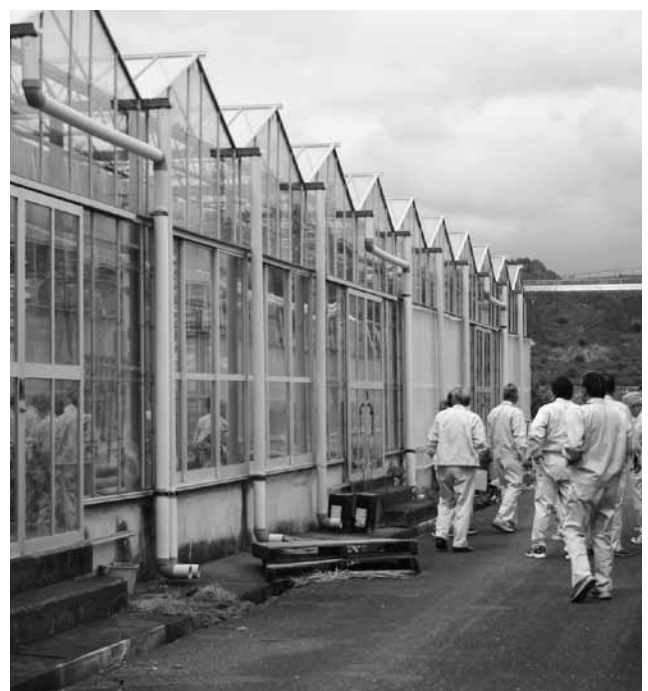
売却された花卉団地
