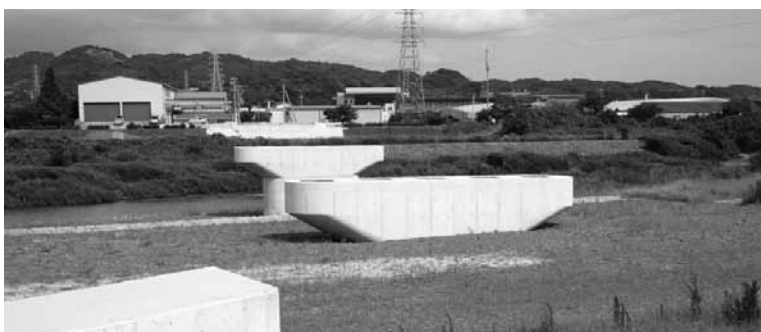
建設中のみなべ新橋
