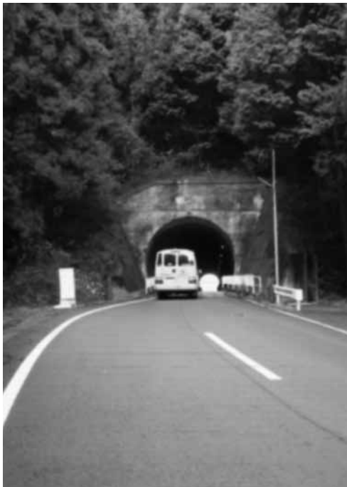
改修を望む高城隧道
