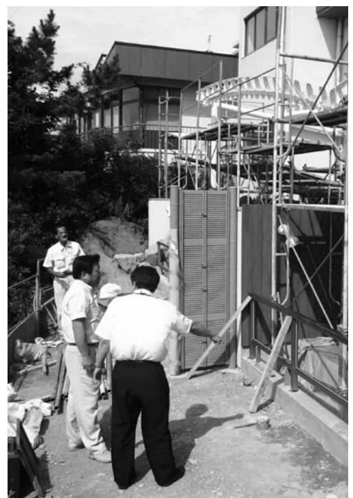
国民宿舎露天風呂(工事現場)
