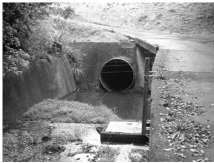
高城中の排水管
