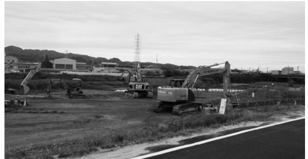
新殿開南部川線橋梁工事
