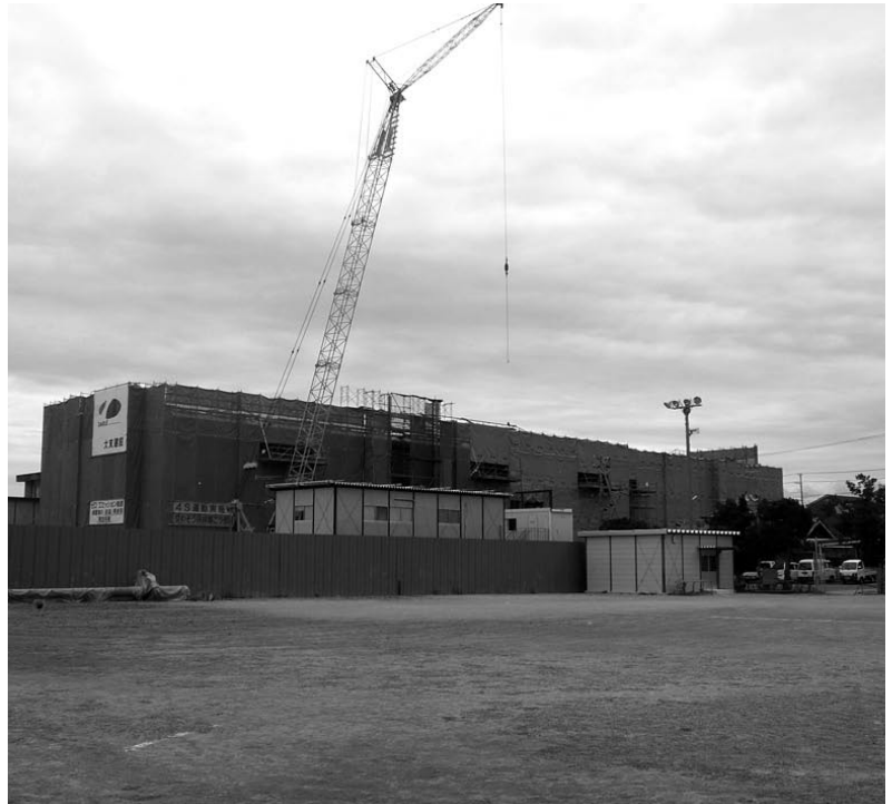
改築中の南小新校舎
