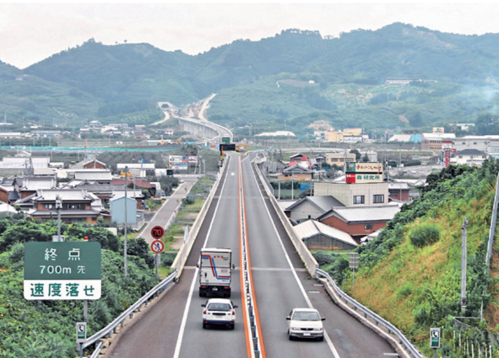
南進する高速道路
