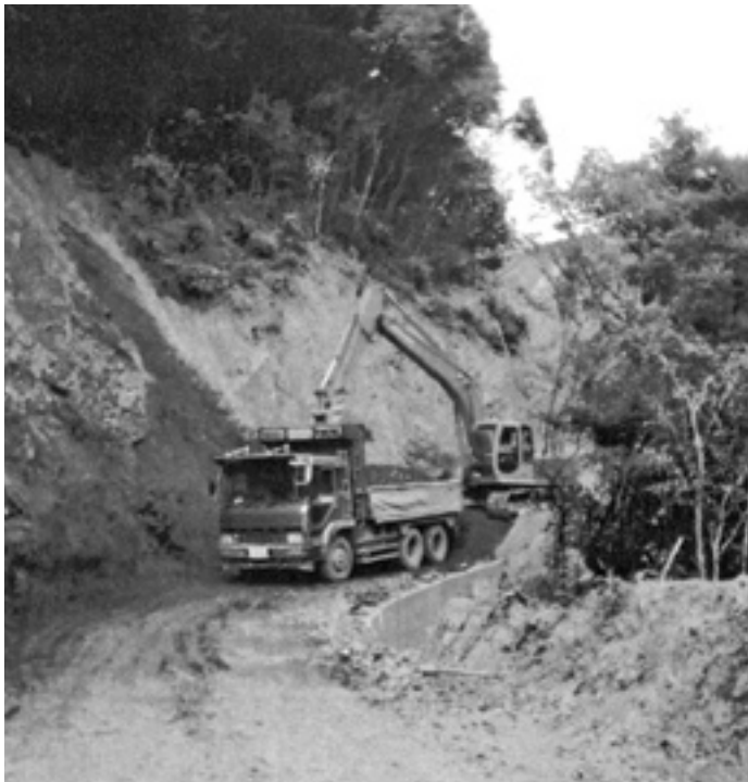
林道工事現場(清川地内)
