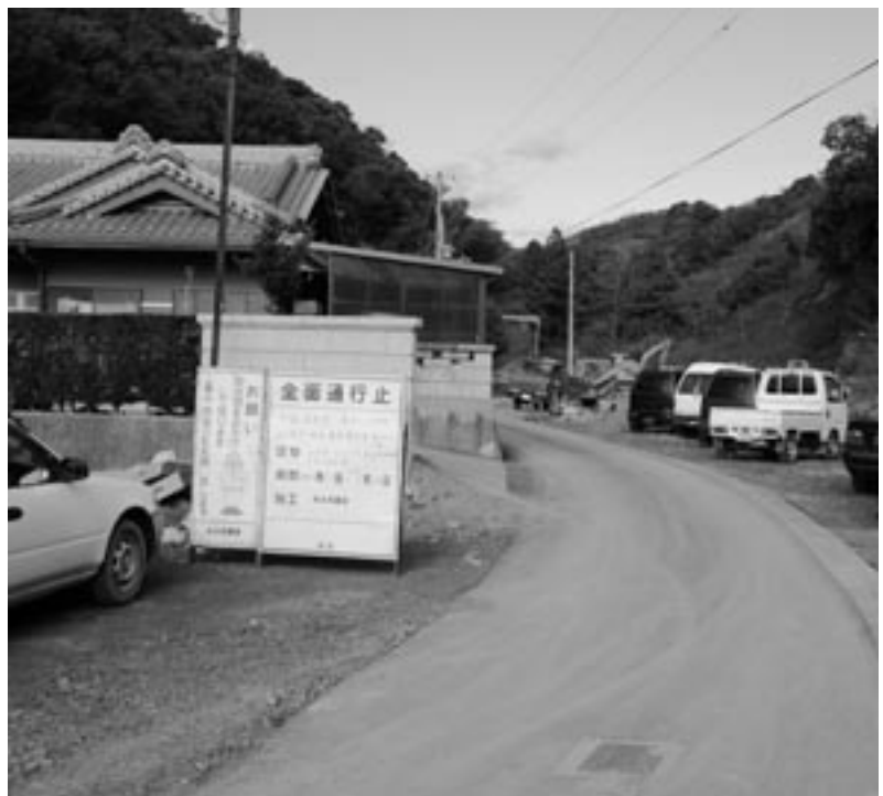
工事現場 (東本庄 本郷)
