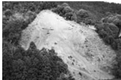
山崩れ復旧工事開始
