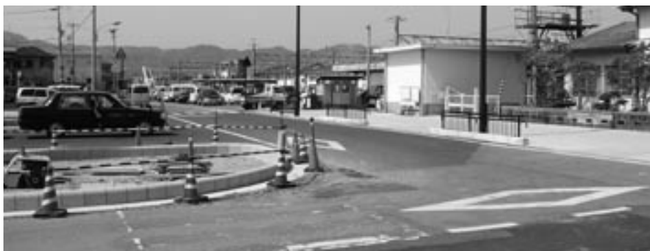
整備中の駅前広場
