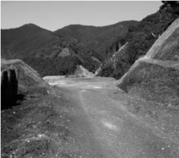
現在工事中の林道
