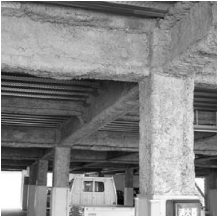
アスベストの心配がないうめ振興館駐車場
