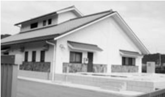
西本庄浄化センター
