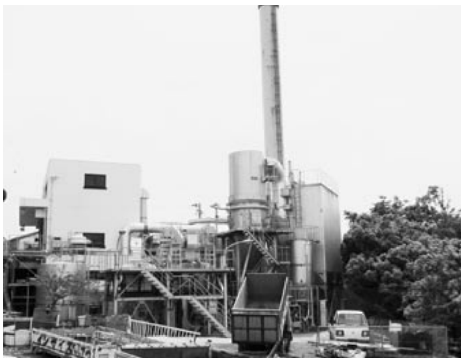
改修されるごみ焼却炉
