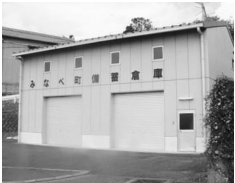
備蓄倉庫（埴田）
