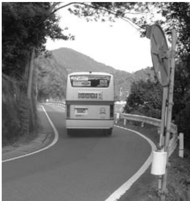
国道424号（清川石倉地内）
