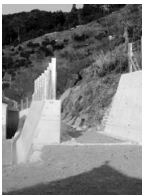
急傾斜地崩壊対策事業
