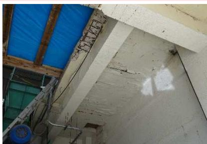
塵芥処理施設天井 鉄筋露出
