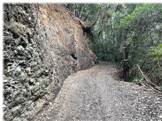
＜道路拡幅のためのり面を掘削＞
