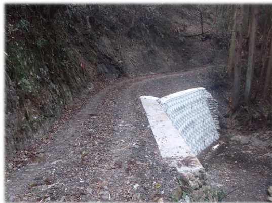
＜コンクリートブロック積みで補修＞
