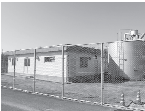
津波浸水想定区域内(気佐藤)の浄水場
