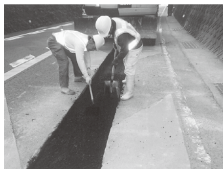
山内の水道管布設工事
