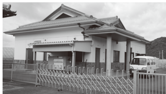
下水道との統廃合を進めている本郷処理場
