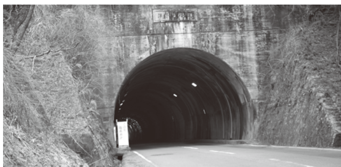
災害復旧工事に伴うトンネル工事など国道改良工事がはじまります。
