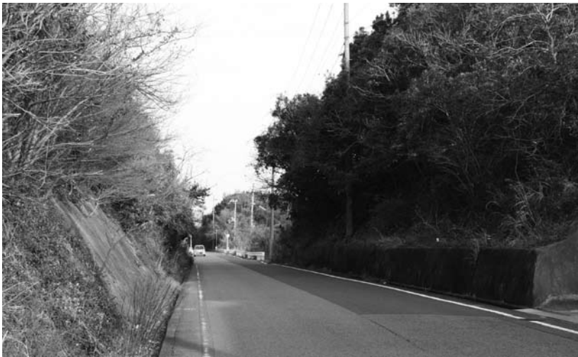
町道埴田界線の法面保護工事が予定されています
