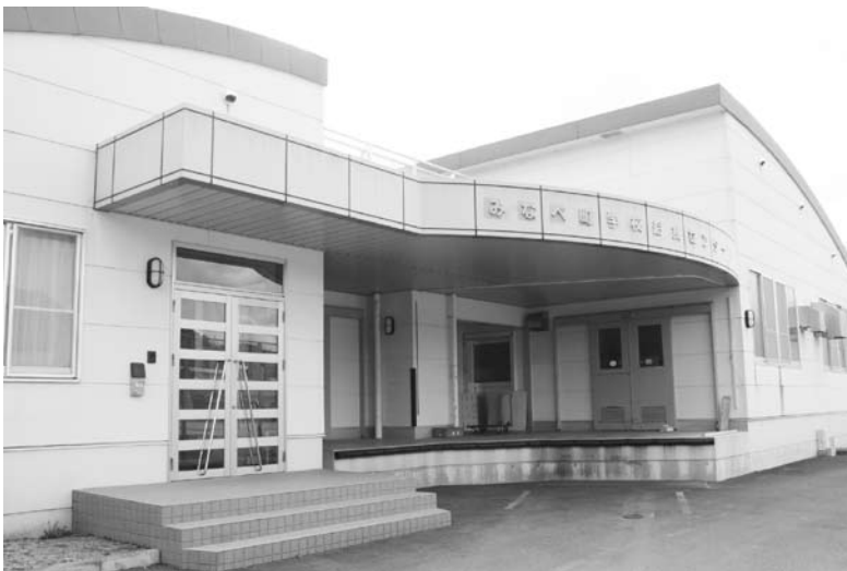
整備が予定されている町学校給食センター
