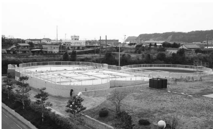
みなべ浄化センターの増設工事が現在施工中です
