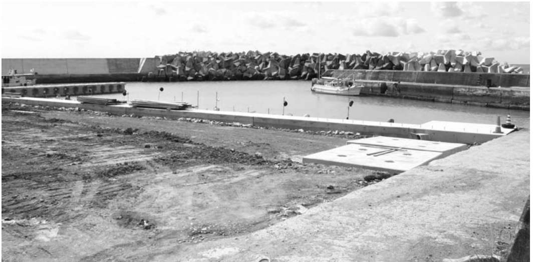
岩代漁港施設整備工事が引き続き施工中です
