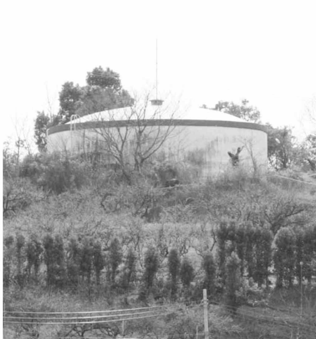
2ヶ年にわたって新設改良が予定されている東部配水池
