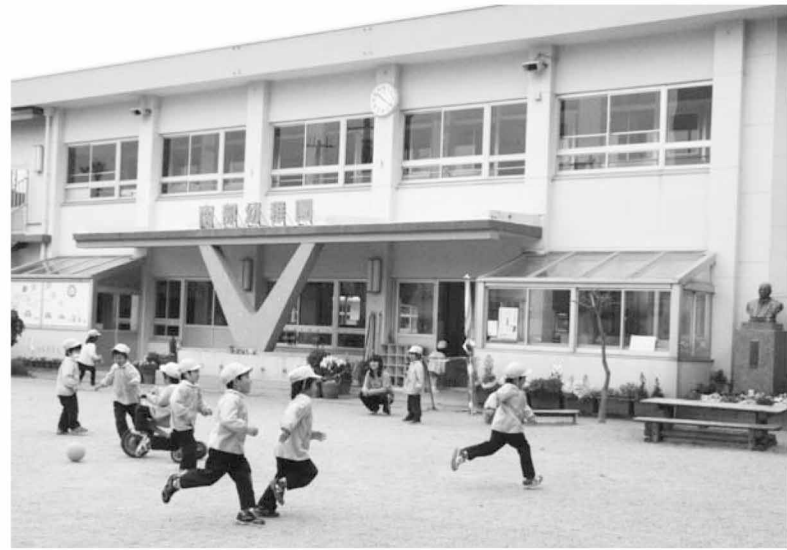
耐震補強工事が行われる南部幼稚園
