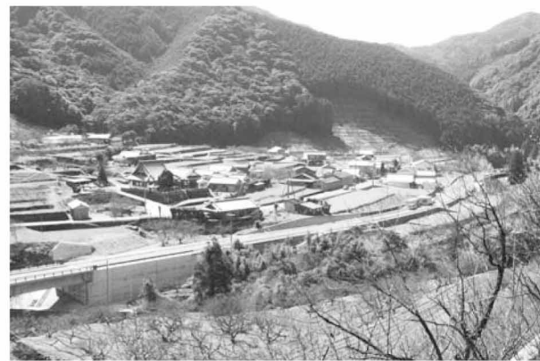
国道424号改築工事が進められています
