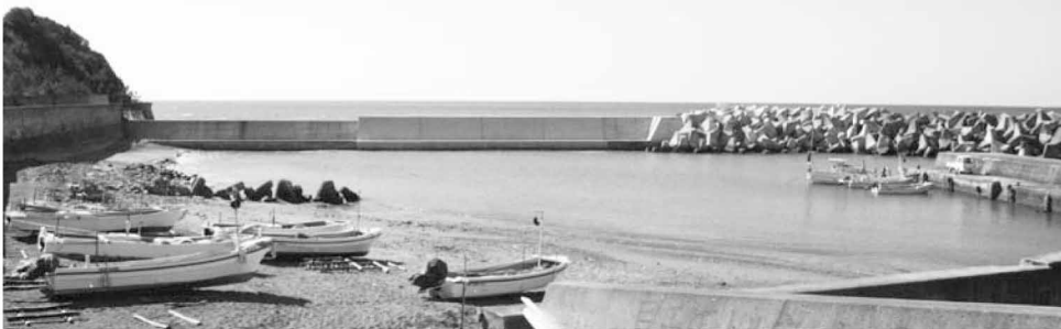
岩代漁港漁港施設整備工事が現在施工中です
