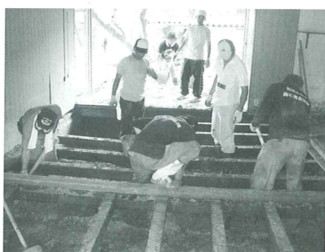
民家で土砂の撤去作業(防府市)
