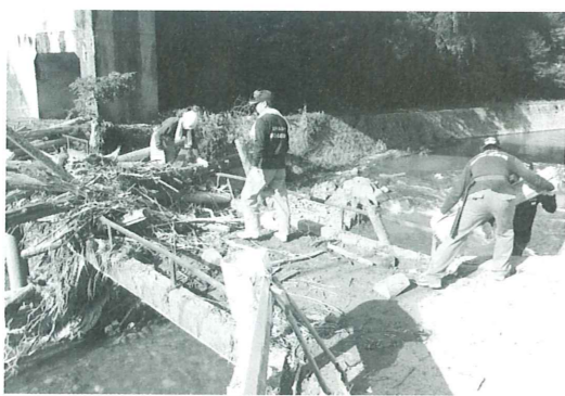
橋の復旧作業(佐用町)
