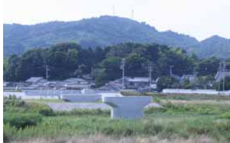
ただ今、橋台と橋脚を工事中です(町民広場付近から撮影)
