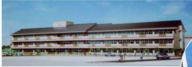
新校舎は鉄筋コンクリート3階建てで、地震などの揺れを半減させる免震構造が施されます。建設費は約10億5000万円で、平成19年12月の完成予定です。
