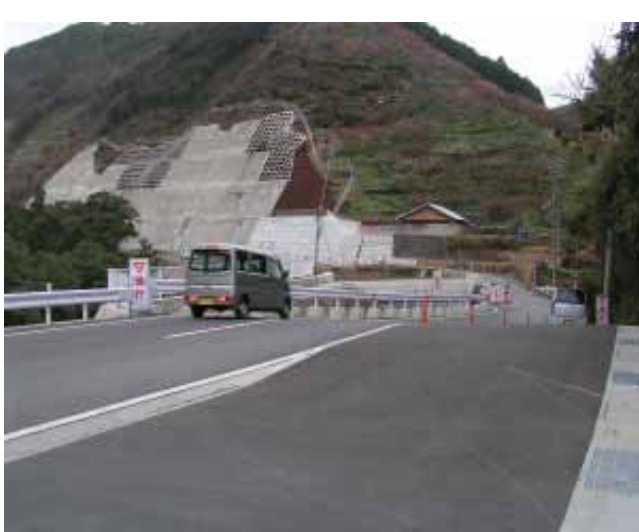
滝地内の国道424号線で、早期完成を目指して拡幅工事が進んでいます
