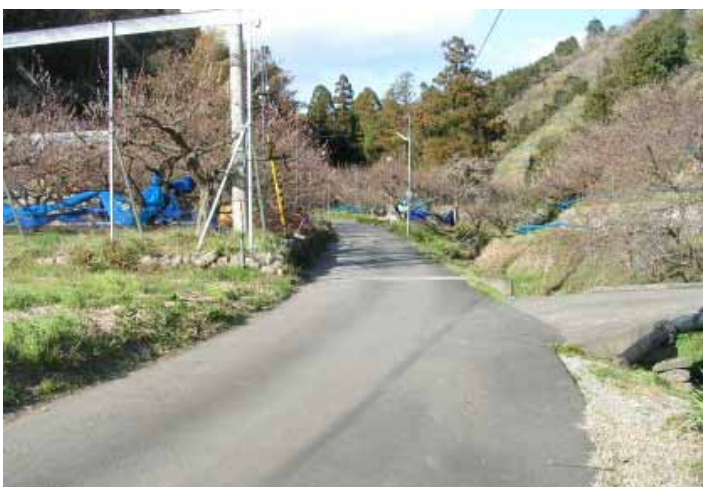
東本庄 小倉谷地区内への農免道路新設に備えて、先ず測量試験などを行います
