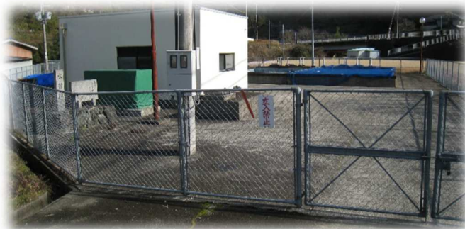
清川浄水場（正面入口）
