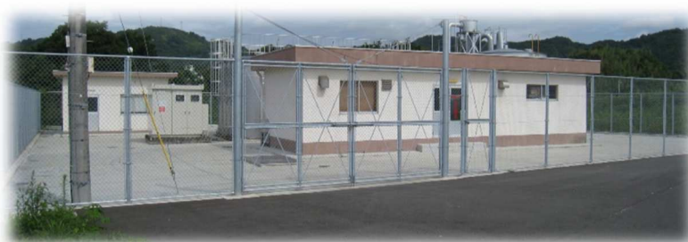
みなべ浄水場
