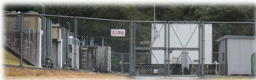
市井川浄水場
