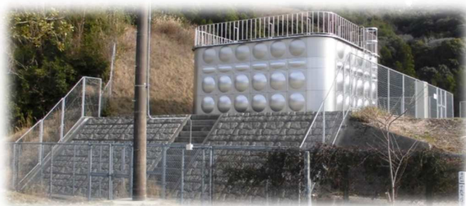
高城低区配水池
