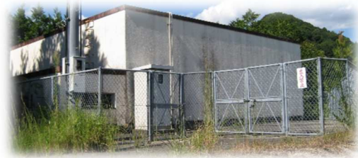
軽井川配水池
