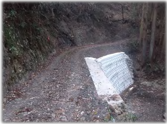
〈コンクリートブロック積みで補修〉
