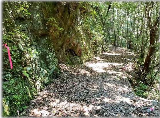
〈幅員が狭くなっている箇所〉
