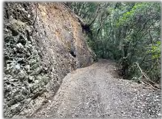
〈道路拡幅のためのり面を掘削〉
